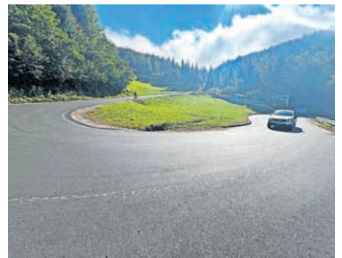
Obnovljen odsek ceste Stahovica–Črnic / FOTO: ALEŠ SENOŽETNIK
