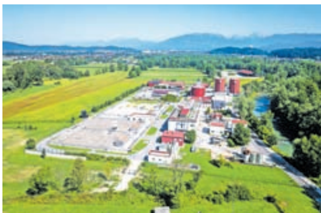
Centralna čistilna naprava Domžale - Kamnik
