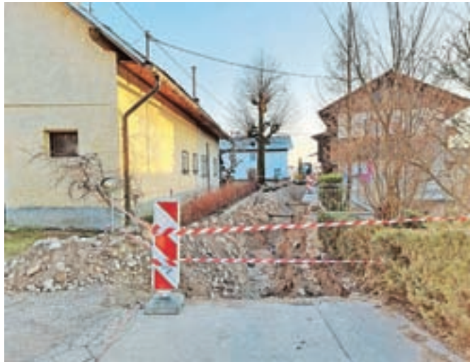
Gradbena dela na Zduši / FOTO: JASNA PALADIN
