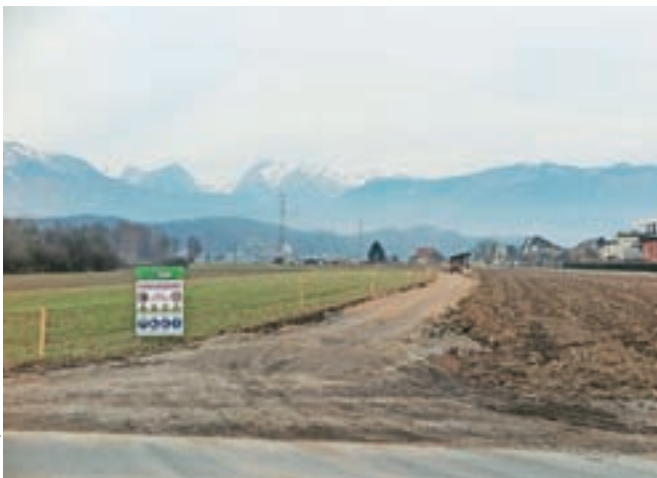
Gradnja kolesarske povezave na Dupliškem polju
