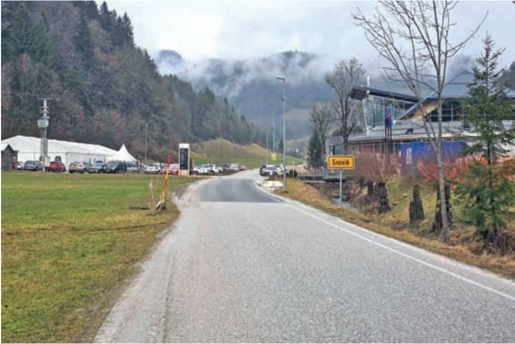
Občina načrtuje tudi obnovo cestne infrastrukture in gradnjo kanalizacije v Snoviku.
