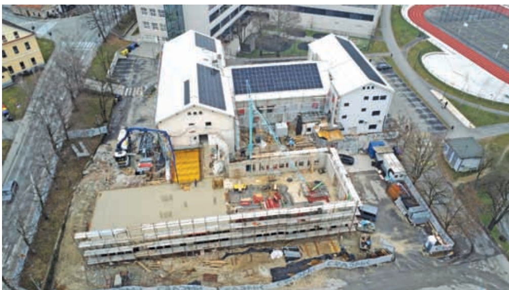
Obnova kamniške knjižnice bo predvidoma dokončana jeseni. / FOTO: OBČINA KAMNIK
