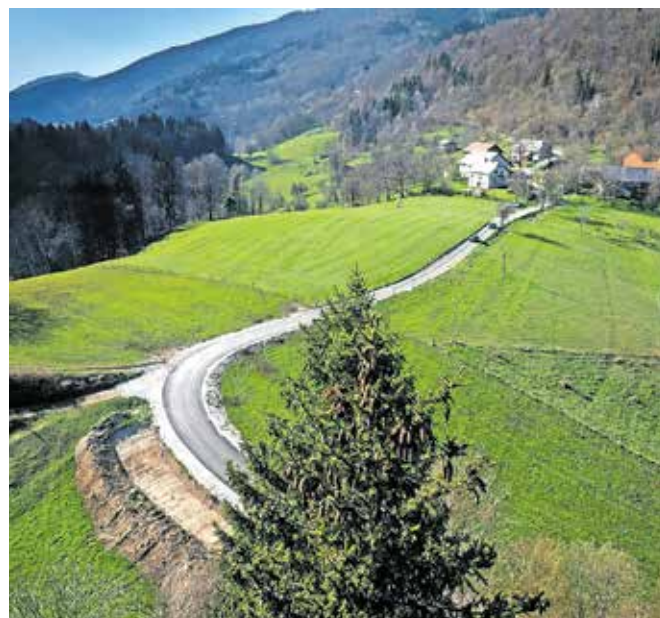
V zadnji etapi, ki so jo začeli novembra lani, so asfaltirali 1250 metrov trase. / FOTO: MIH LINDIČ/OBČINA KAMNIK
