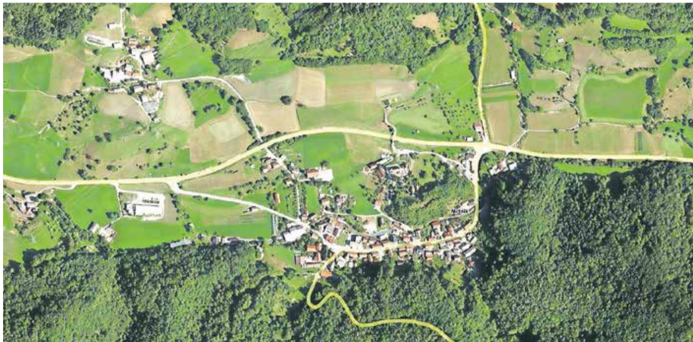
Na območju Motnika bodo zgradili okoli 2675 metrov kanalizacijskega sistema / FOTO: PISO
