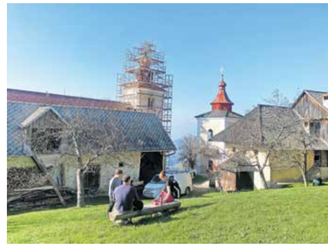
Obnova zvonika na cerkvi sv. Primoža in Felicijana
